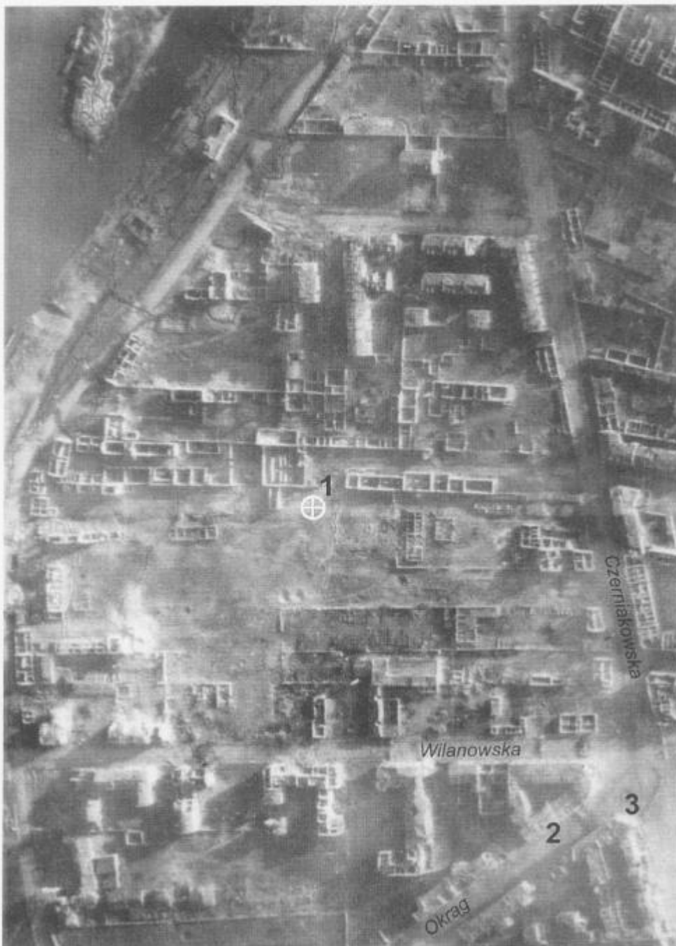
Zdjęcie lotnicze terenu walk na przyczółku Czerniakowskim: 1 – studzienka, w której autor przesiedział kilkanaście godzin w dniu 15 września, 2 – żółta ściana, 3 – czerwony dom
